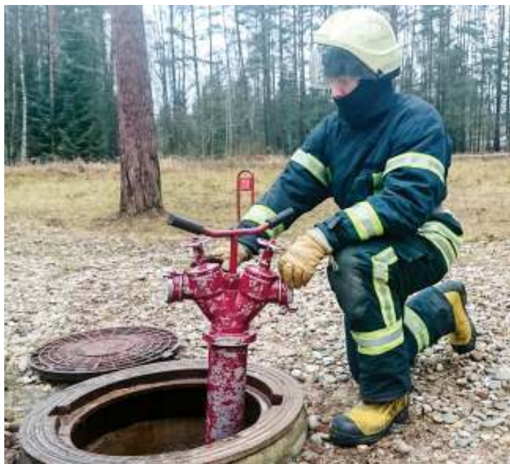
141 pav. Hidranto kolonėlės prisukimas
