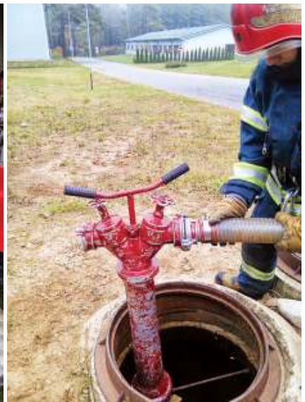
144 pav. Vandens surinktuvo prijungimas
