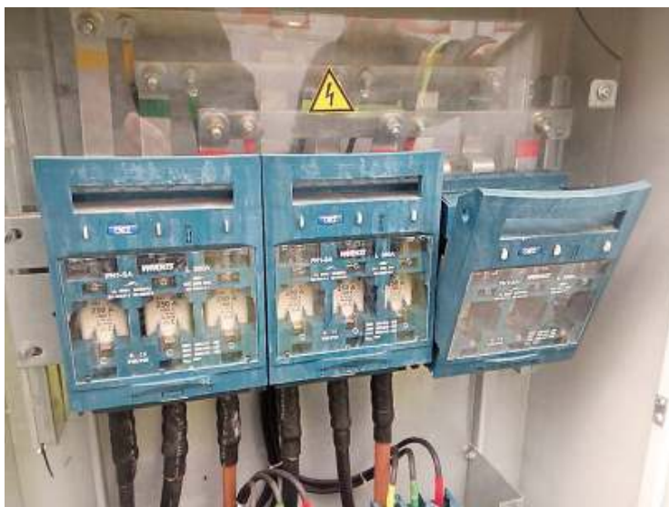
72 pav. Elektros kirtiklis
