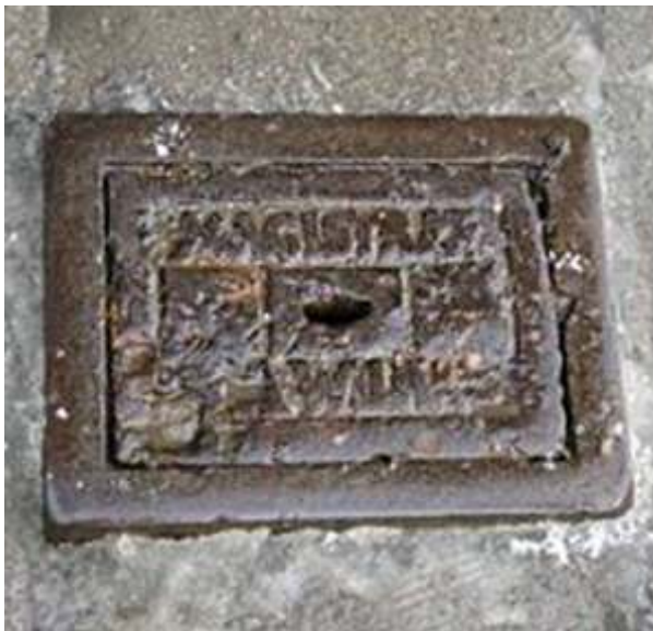
87 pav. Talino tipo hidrantas
