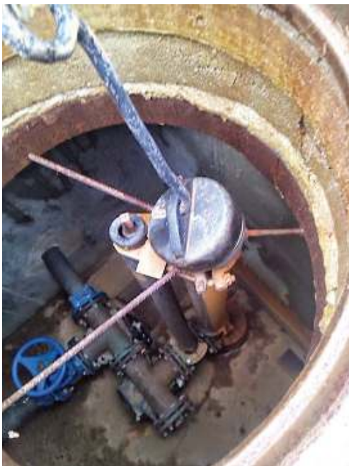
140 pav. Hidranto dangtelio atidarymas
