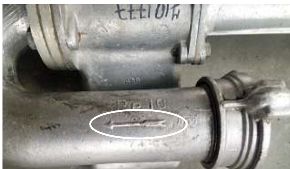
111 pav. Hidroeleveatoriaus vandens tekėjimo krypties rodyklė
