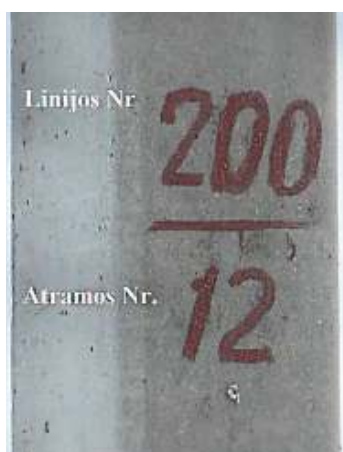
75 pav. Elektros atramos žymėjimas
