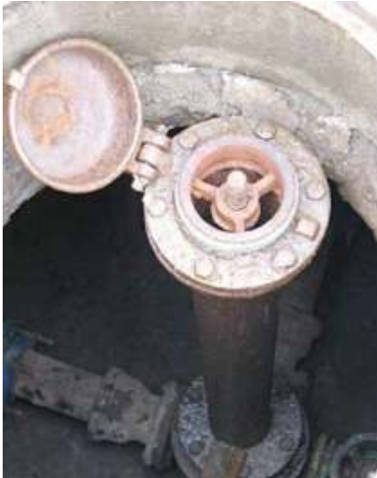
83 pav. Maskvos tipo hidrantas
