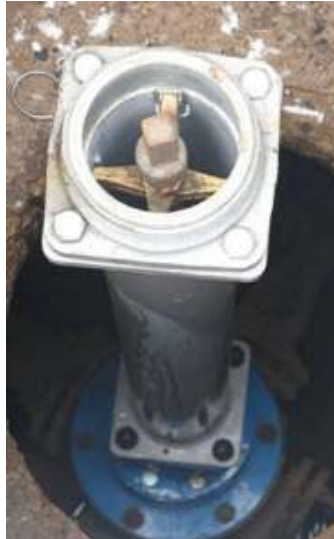
84 pav. DUO tipo hidrantas
