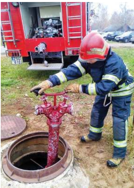
142 pav. Hidranto vožtuvo atsukimas
