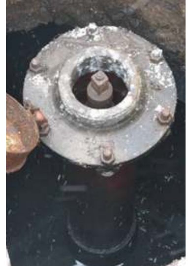
85 pav. PAM tipo hidrantas
