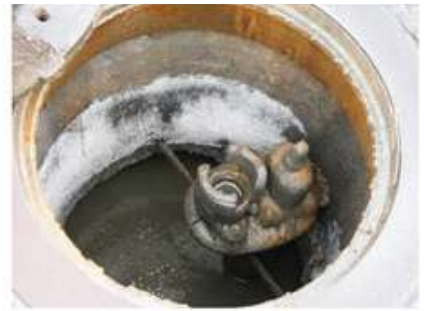
85 pav. PAM tipo hidrantas
