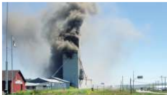
59 pav. Gaisras grūdų elevatoriaus viršutinėje bokšto dalyje
